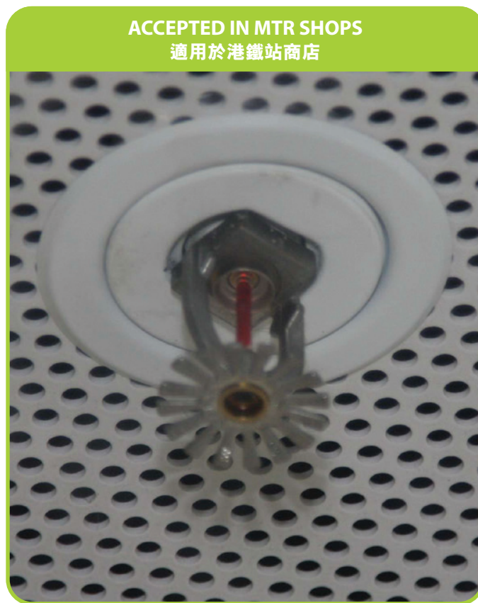
Sprinkler Head (Quick response type at 68°C) 花灑頭（攝氏68度快速反應類型）
